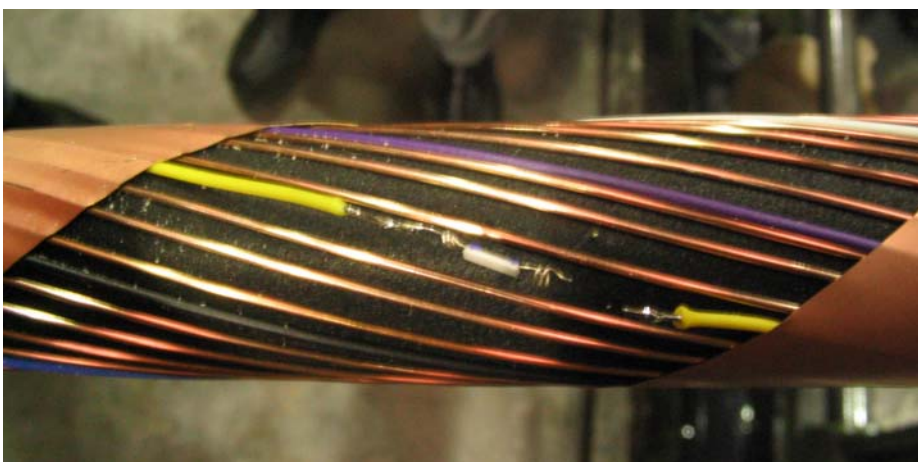
Slika 3 Prikaz termootpornika ugrađenog u ekran SN kabela XHE 49
